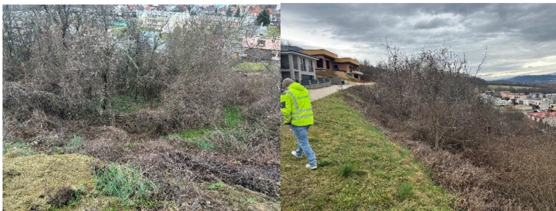
Obr. 8 Antropogénno-zosuvný reliéf v centrálnej časti ulice Kopanice a deformovaná cesta. Fig. 8 Anthropogenic-landslide relief in the central part of Kopanice Street and the deformed road.
