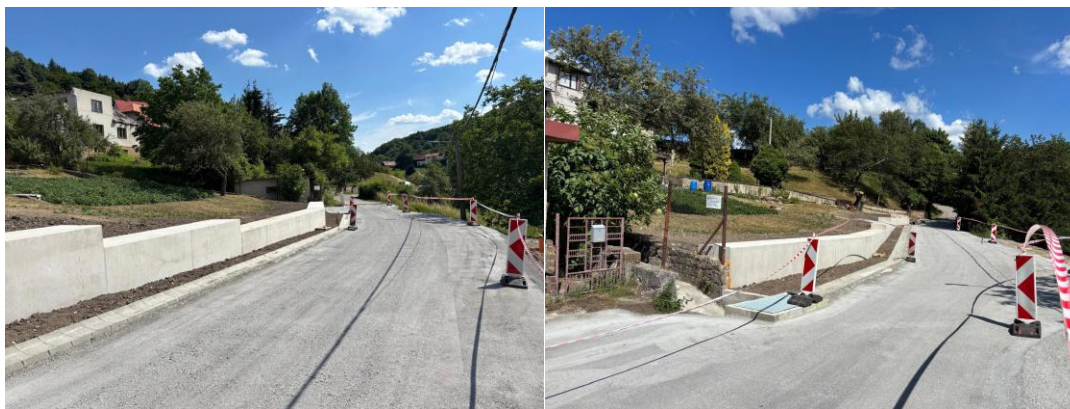
Obr. 13 Pohľad na dokončený oporný múr a zabezpečenú komunikáciu. Fig. 13 View of the completed retaining wall and secured road.
